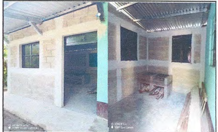
Foto 2: Area frontal, donde se realizo el mejoramiento la estructura tipo portico para la cocina, con paredes de concreto, losa de piso de concreto, techo de lamina, ventanas, puerta y polleton.
