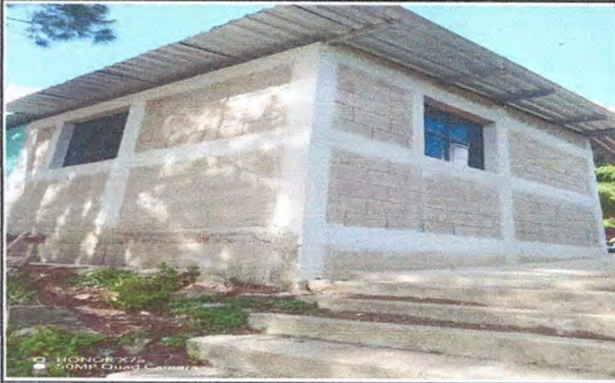
Foto 1: Area lateral donde se realizo el mejoramiento de la estructura tipo portico para la cocina, instalación de techo y ventanas.
