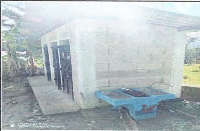
Foto 3: Area lateral, donde se realizo el mejoramiento del techo, piso de concreto, puertas, paredes, sanitarios lavables y la colocación de la pila para el uso de los niños y niñas.
